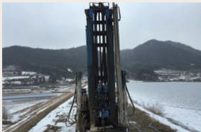
02 천공기 이동 및 설치
